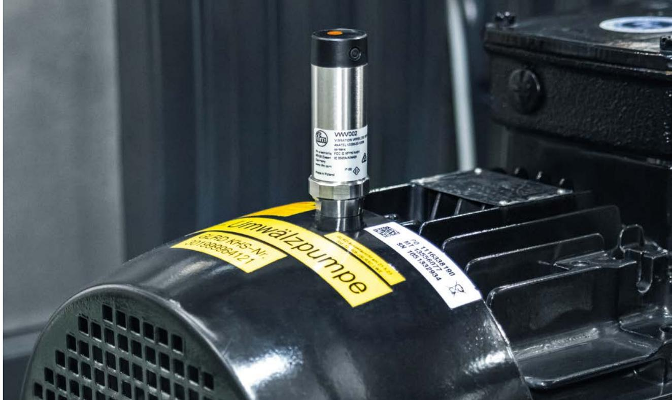
循环泵上的无线振动传感器可根据DIN ISO 10816标准对整体振动状况进行可靠的间歇性监测。
