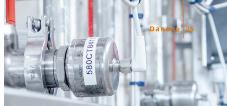
LDL200电导率传感器可确保正确、高效地执行CIP过程。
