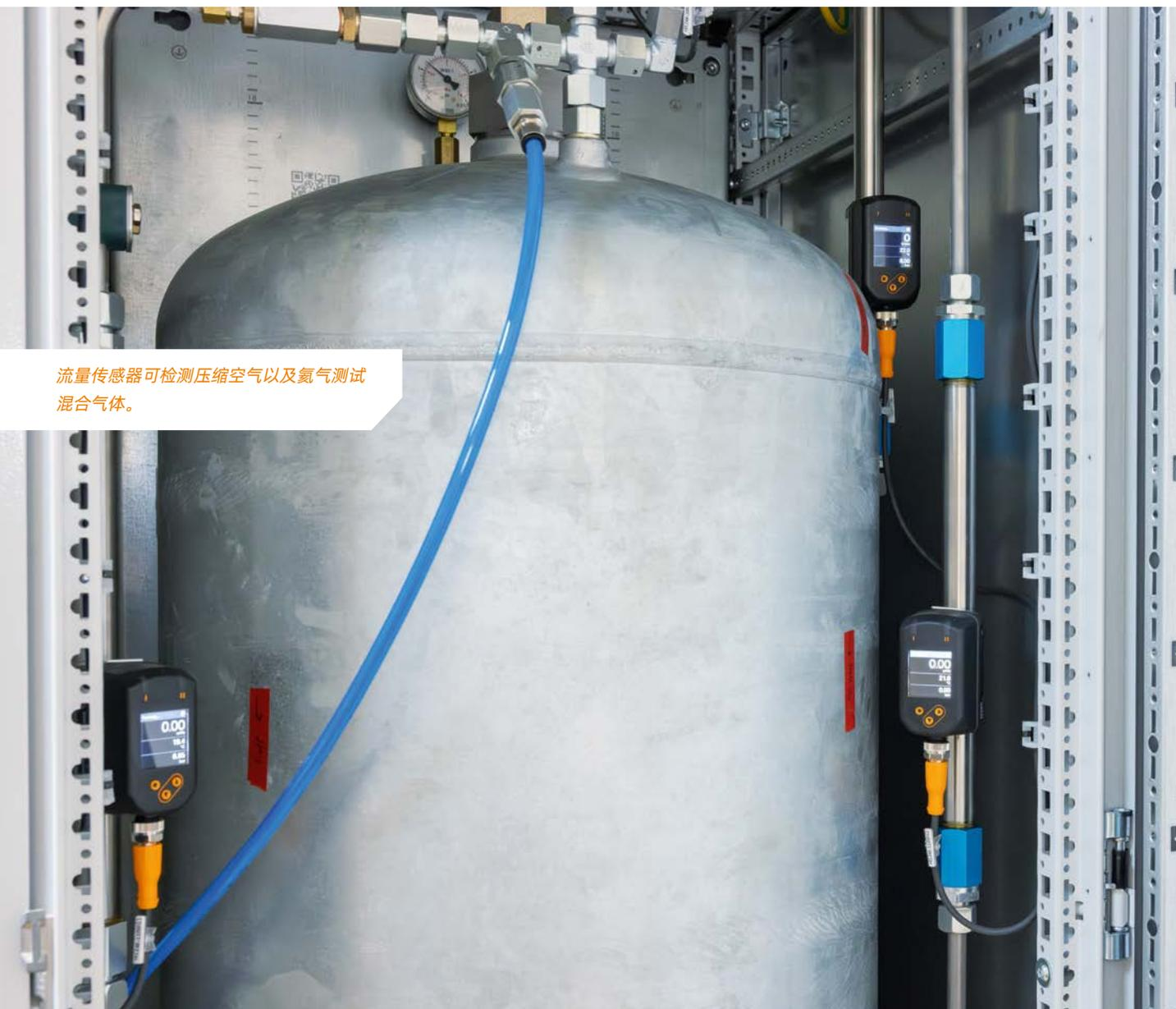
流量传感器可检测压缩空气以及氮气测试混合气体。
