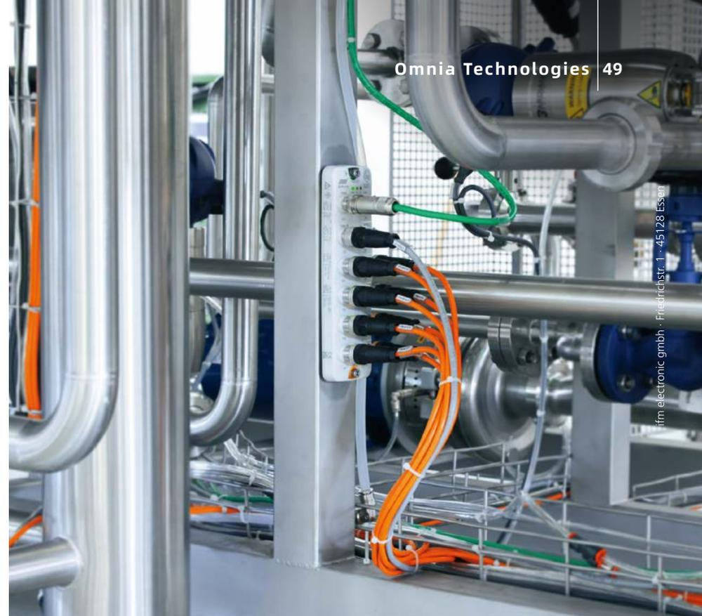
现场兼容型IO-Link主站分布式采集传感器数据，并将数据以捆绑形式传输至控制器。
