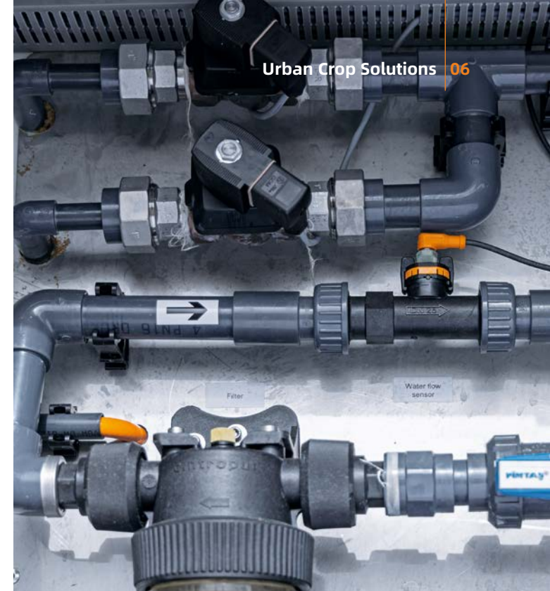
水位、水温和水流量：作物质量的三大决定性因素都由ifm传感器监测。
