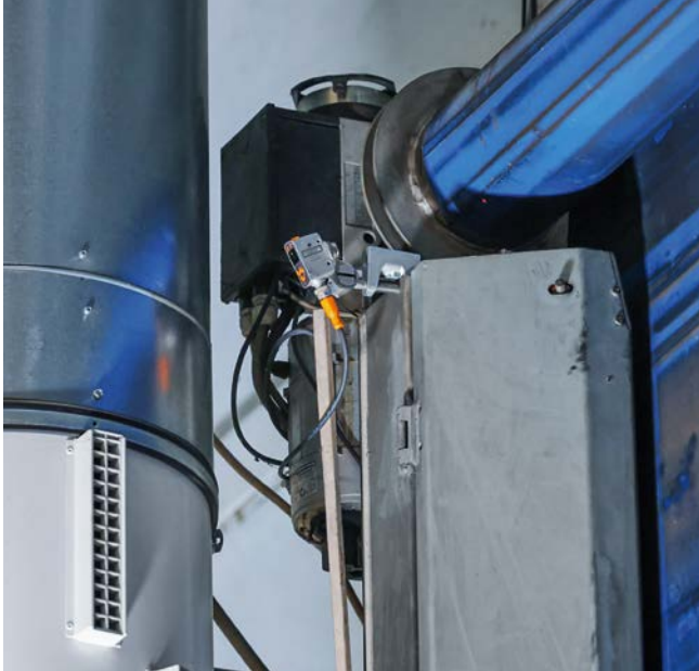
光电传感器检测门的开启或关闭状态。
