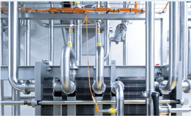
工厂的核心：板式热交换器，用于精确控制原料奶的温度
