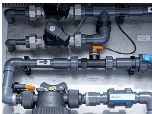
水位、水温和水流量：作物质量的三大决定性因素都由ifm传感器监测。
