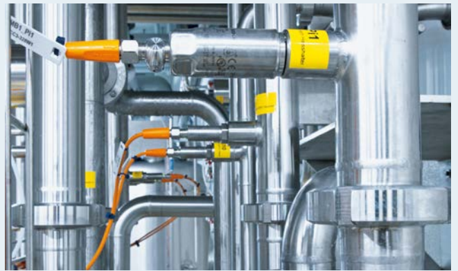
紧凑且卫生：采用齐平陶瓷测量单元的PM15系列压力传感器
