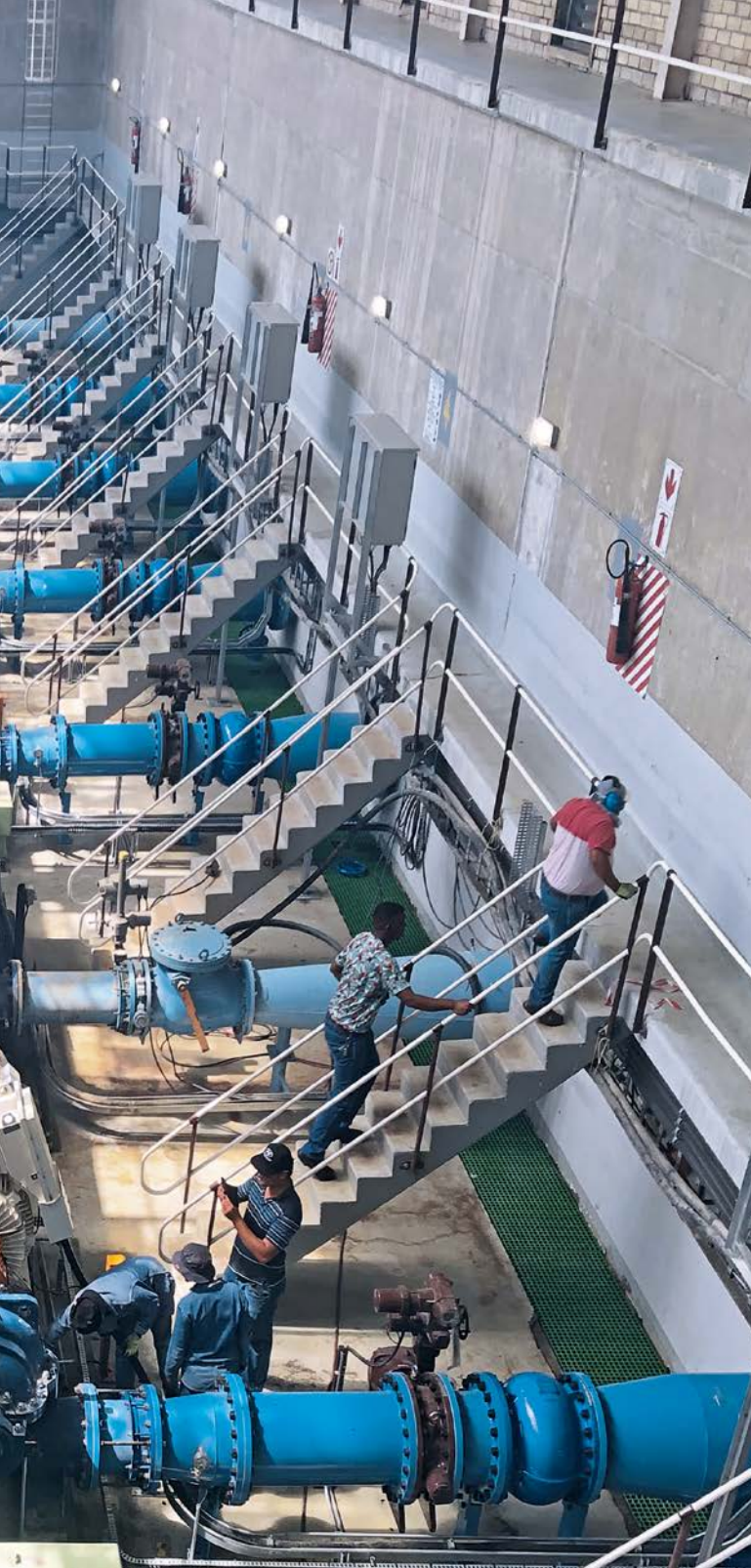
Midvaal的高扬程泵站。5个较新的电机-泵套件（灰色电机外壳）配有IO-Link传感器和状态监测解决方案。
