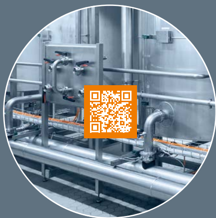
moneo|RTM: 使用双组分浇注树脂进行储罐液位监测。
