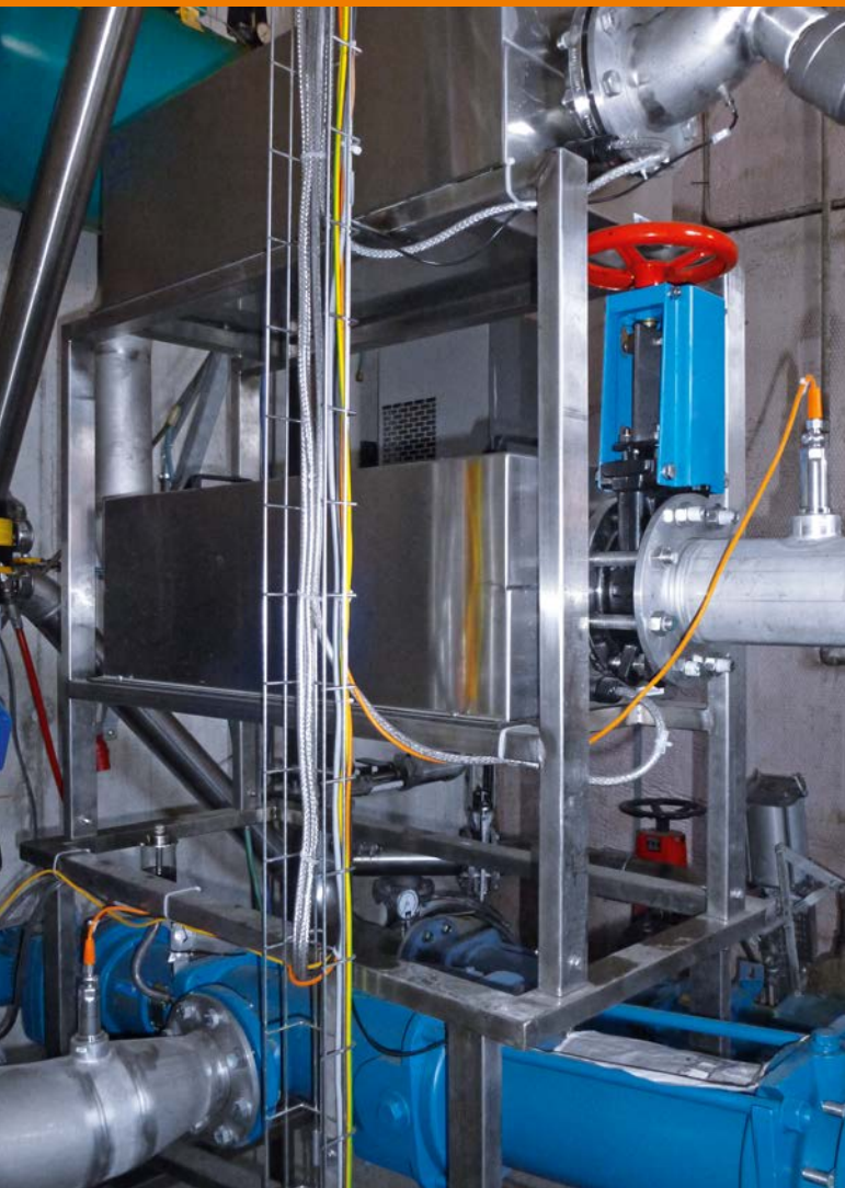
超声分解厂对生物质进行处理，进一步提高能源产量。
