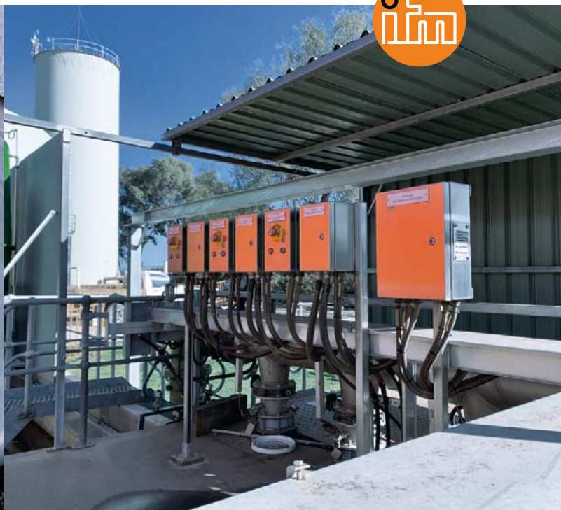
由于采用IO-Link技术，MVQ的安装和更换十分简单。此外，它甚至能抵御澳大利亚气候的直接影响。
