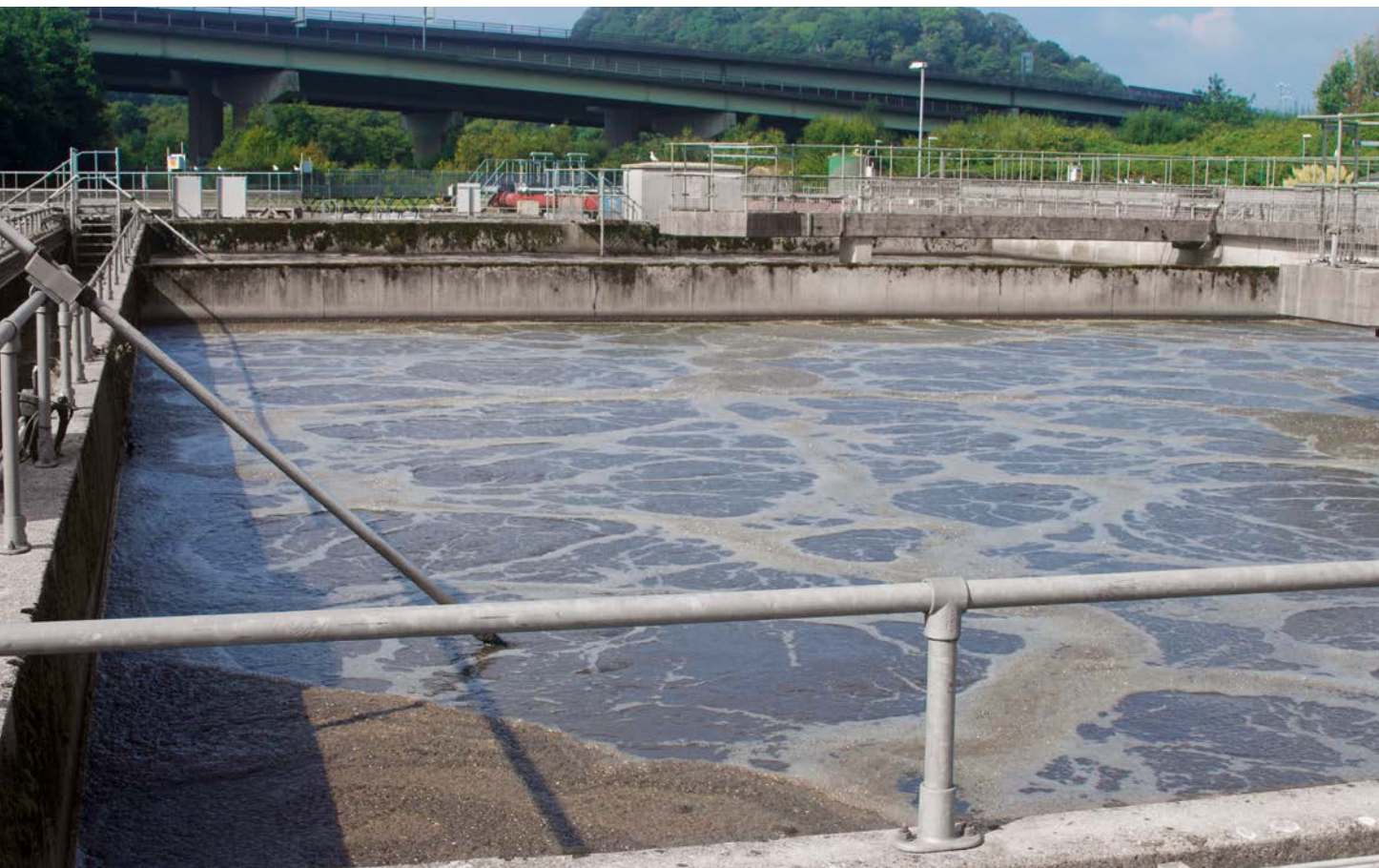
Marsh Mills使用强力的鼓风机（风量高达390立方米每分钟）将空气输送进曝气池。
