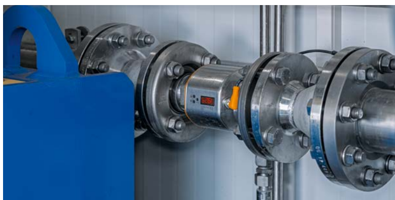
核心测量值：电磁感应流量传感器监测进入离心机的污水污泥量。
