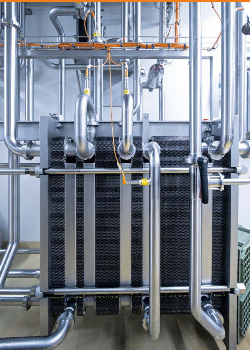
工厂的核心：用于对原奶进行准确温度控制的板式热交换器。
