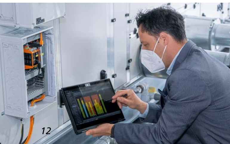
Rafael Cannas检查操作界面上清晰显示的滚动轴承的状态。
