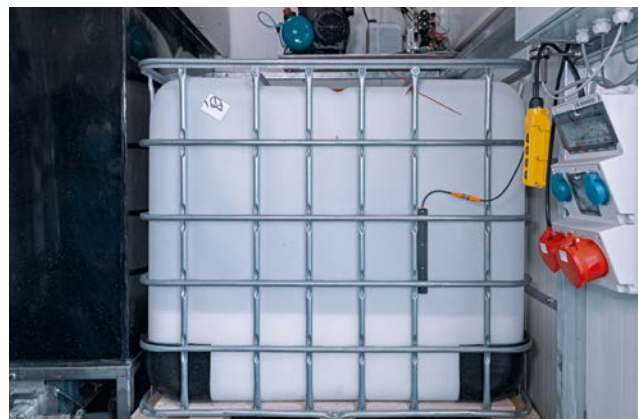
电容式接近开关透过容器壁检测聚合物浓缩物的液位，并在需要重新加注时发出信号。
