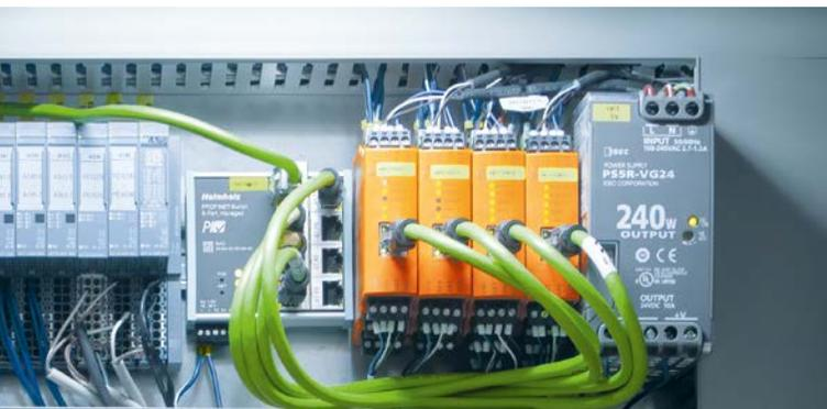
控制柜中的评估单元处理振动传感器采集的数据，并将结果通过以太网传输至网关，即ifm的IIoT控制器。
