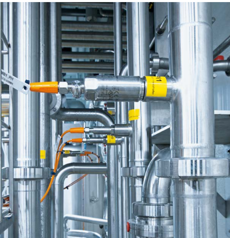
紧凑且卫生：PM15系列压力传感器采用齐平式陶瓷测量元件。
