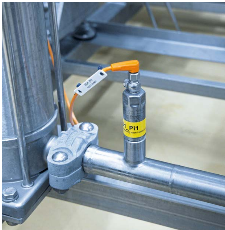
小管径的理想选择：采用G1/2过程连接的PM15系列压力传感器应用于反渗透系统的进料侧。
