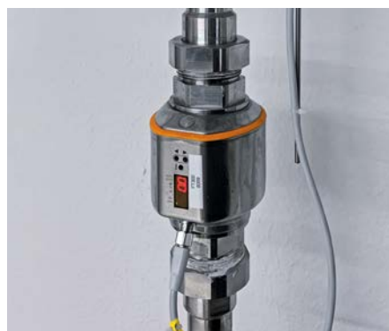
流量传感器通过IO-Link将多个测量值发送到控制系统。
