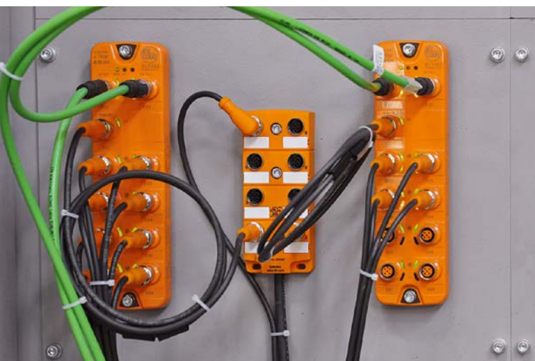
传感器的信息在IO-Link主站中绑定，并通过IoT连接（绿色电缆）转发，以实现基于IT的评估。
