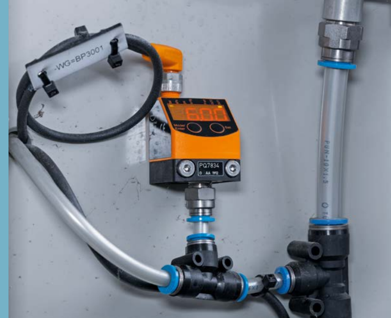
PQ系列压力传感器监测开关阀门所需的压缩空气。
