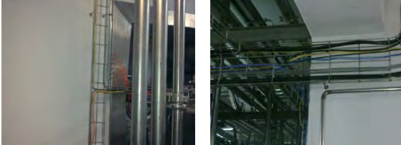
电缆的用量大幅减少，线缆桥架里大量电缆被一根AS-i总线替代
