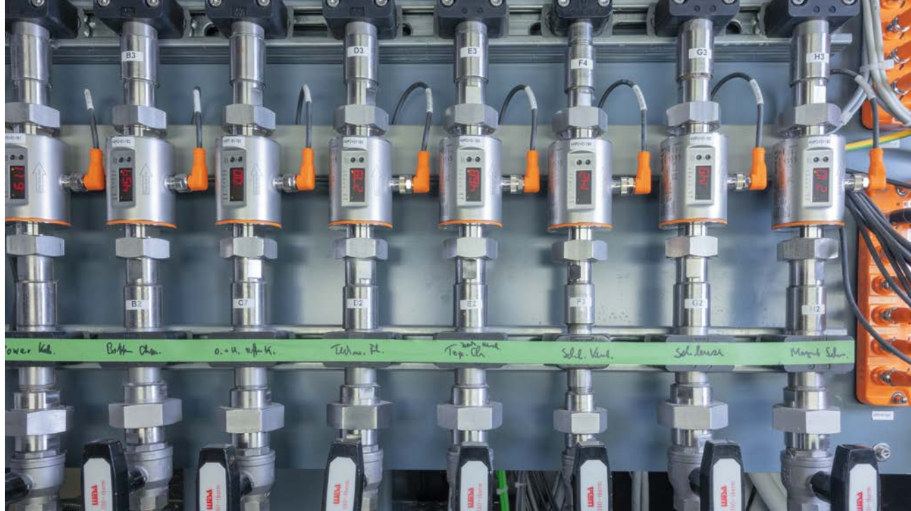
流量传感器对柴氏系统的冷却回路进行监测。
