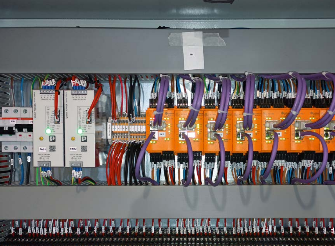
IO-Link主站和振动传感器的振动诊断模块负责采集数据，并将其以打包形式传输至IT层级。
