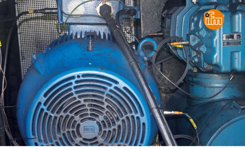
鼓风机电机上的振动传感器可提前检测到初期损坏问题,避免发生重大损坏。
