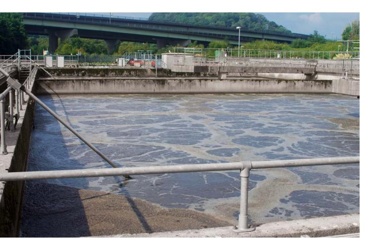
Marsh Mills使用强力的鼓风机(风量高达390立方米每分钟)将空气输送进曝气池。
